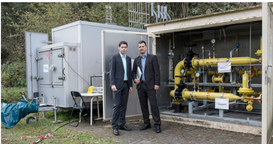
Holger Erdmann, Leiter der Leitstelle (links), und Thomas Wilke, Abteilungsleiter Operatives Assetmanagement, beim Aufbau des Prozessgaschromatographen für einen Feldversuch (Quelle: MITNETZ GAS)
